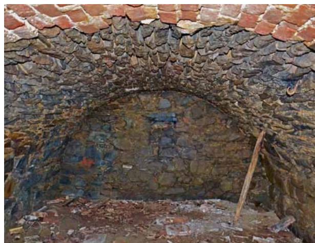
Obr. 24. Vysočany u Ovesných Kladrub, usedlost čp. 7. Starší sklep pod chlévem výměnku, pohled na jižní stěnu. V popředí novější cihelná klenba při vstupní šíři. (Foto K. Knotová, 2013–2014)
