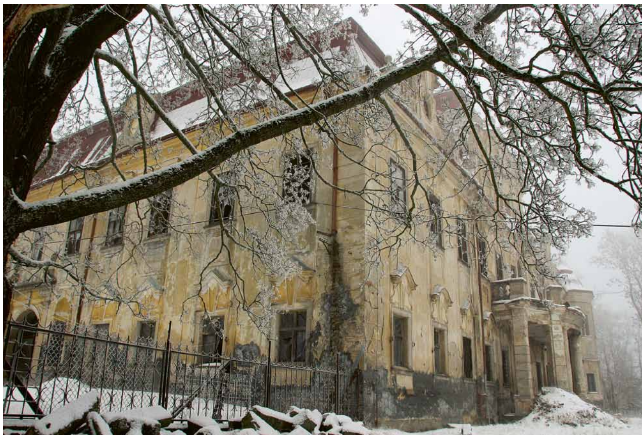
Obr. 11. Velké Dvorce, zámek. Hlavní budova. Pohled od jihu. (Foto Z. Gersdorfová, 2014)
