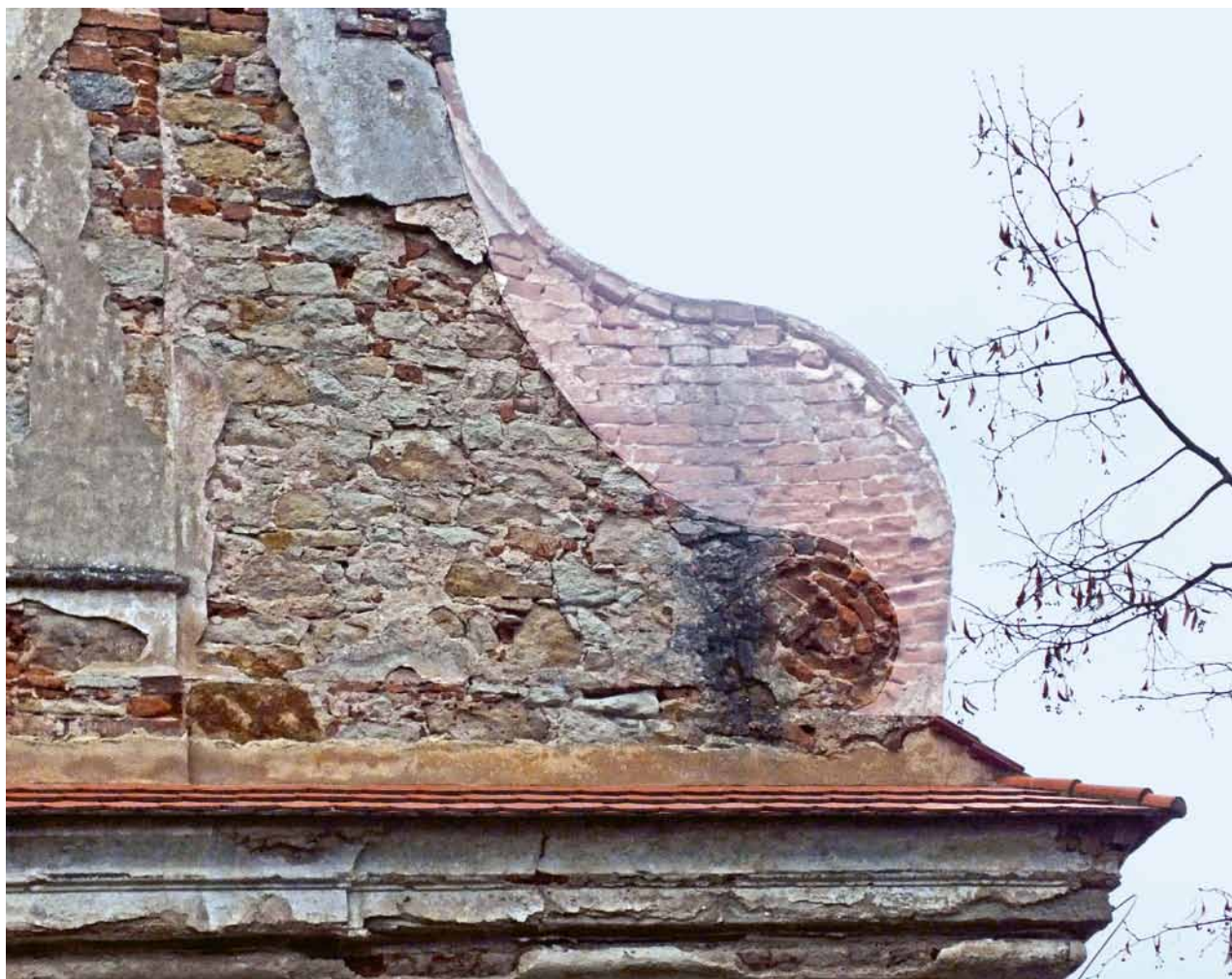
Obr. 8. Ostrovec, kostel sv. Jana Křtitele. Detail volutového štítu hlavního průčelí (dodatečně přizdělá část je zeslabena). (Foto P. Vlček, 2013)
