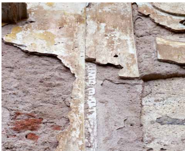
Obr. 9. Ostrovec, kostel sv. Jana Křtitele. Detail lisenového rámce hlavního průčelí po pravé straně portálu s viditelným dodatečným rozšířením. (Foto P. Vlček, 2013)
