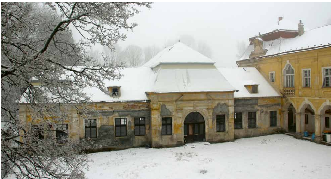
Obr. 12. Velké Dvorce, areál zámku. Hospodářské objekty – jižní křídlo, přiléhající k hlavní budově. Pohled od východu. (Foto Z. Gersdorfová, 2014)
