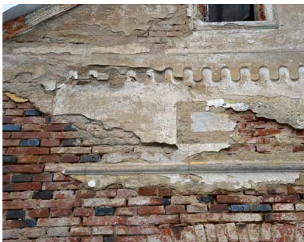
Obr. 19. Vysočany u Ovesných Kladrub, usedlost čp. 7. Detail štítového průčelí hlavního domu. Lze rozeznat dvě vývojové fáze – starší se žlutým nátěrem a obdélníkovými rámy v úrovni polopatra, a mladší s dodatečnou obloučkovou římsou, nárožními lisenami a okenními šambránami. (Foto K. Knotová, 2013–2014)
