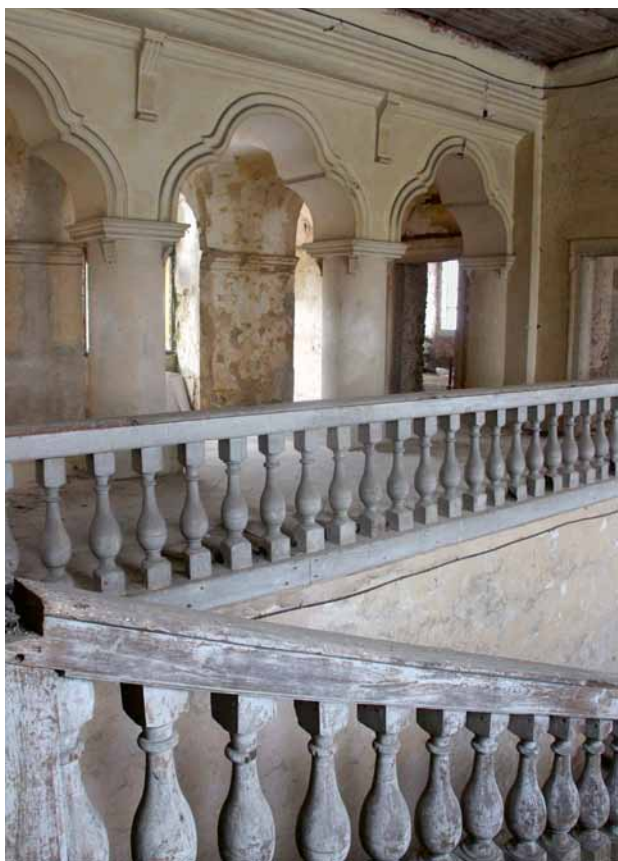
Obr. 13. Velké Dvorce, zámek. Interiér hlavního schodiště. (Foto Z. Gersdorfová, 2014)
