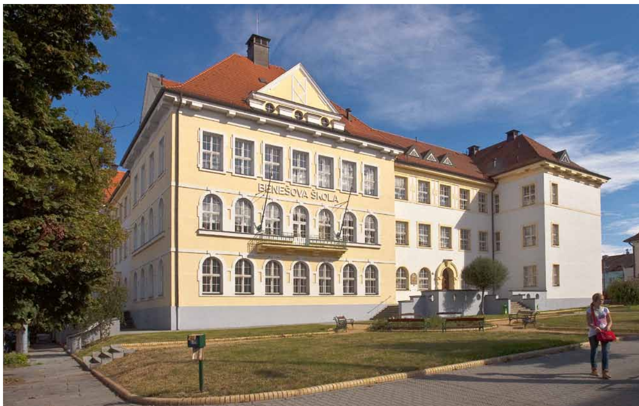
Obr. 2. Plzeň, budova čp. 1692 – Benešova škola, 1923–1925. Navrhl H. Zápál. Pohled na západní průčelí z Doudlevecké třídy. (Foto R. Kodera, 2012)
