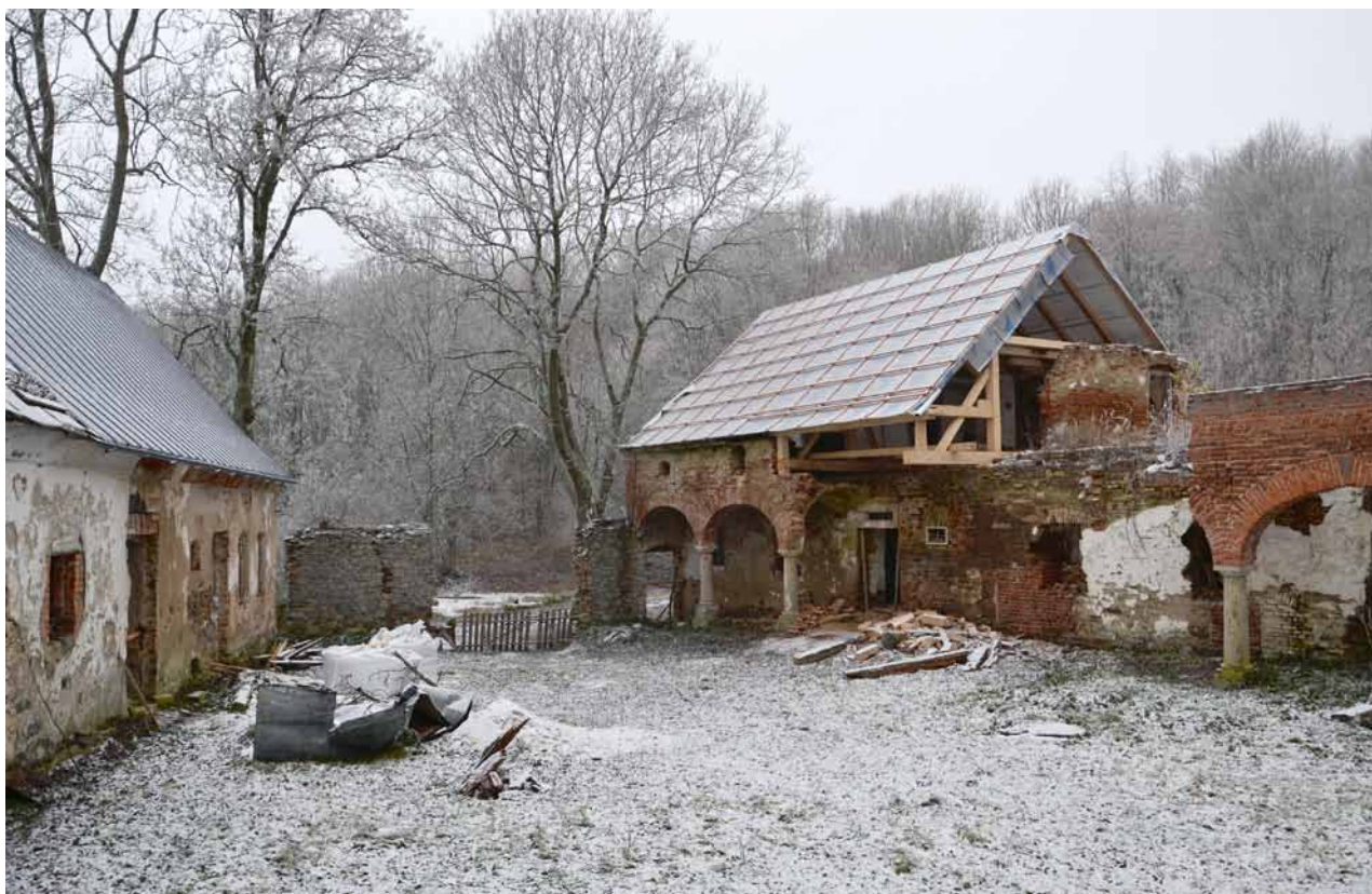
Obr. 18. Vysočany u Ovesných Kladrub, usedlost čp. 7. Západní část dvora. Dvě arkády zápraží směrem k ohradní zdi jsou původní, zadení dvě nově vyžděny. (Foto K. Knotová, 2013–2014)
