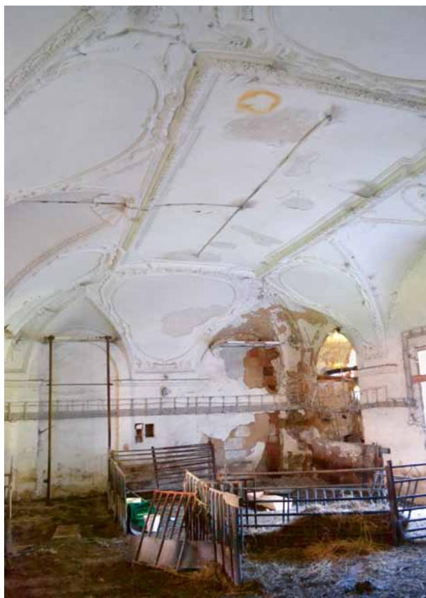
Obr. 14. Velké Dvorce, zámek. Klenutý sál se štukovou výzdobou v přízemí hlavní budovy, využívaném jako stáj pro dobytek. (Foto S. Plešmíd, 2013)
