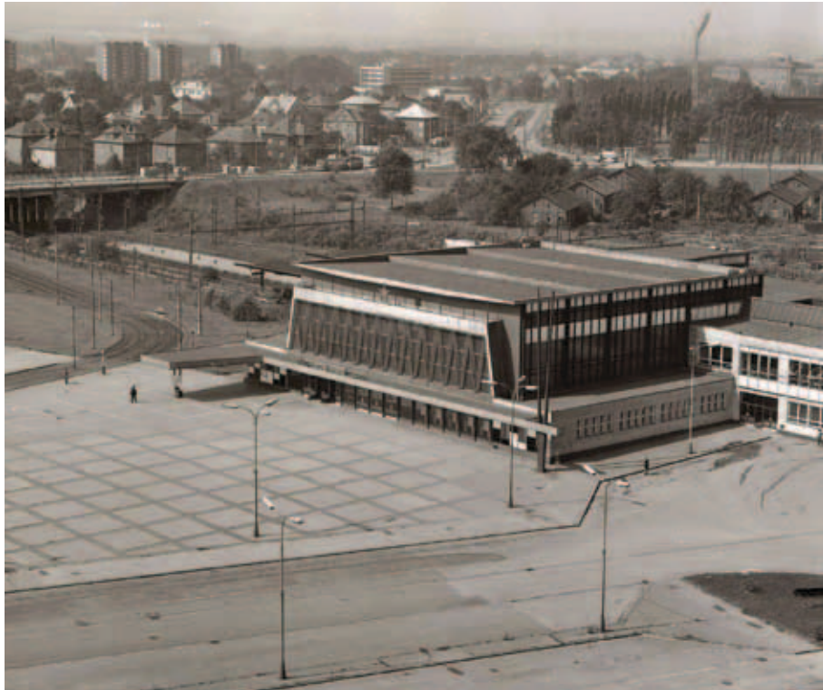
Celkový pohled na výpravní budovu železničního nádraží Ostrava-Vítkovice z nedalekého panelového bytového domu, foto Pavel Čajka, 1975 (Archiv VÍTKOVICE, a. s., fond Vítkovice, s. p., foto – negativy).
