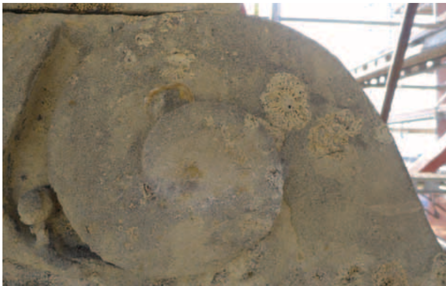
Katedrála Božského Spasitele, detail podstavce kříže v mezivěží, mušlový vápenec, stav po očištění (foto Andrea Stanieková, 2015).
