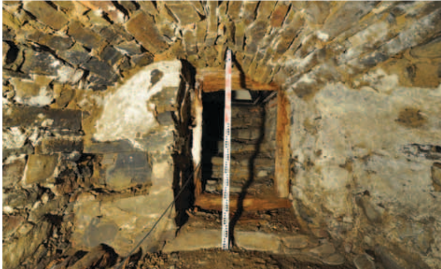
Pohled na západní část kamenného, valeně klenutého sklepa domu č. p. 120 v Bohušově (foto Dagmar Alterová, 2016).
