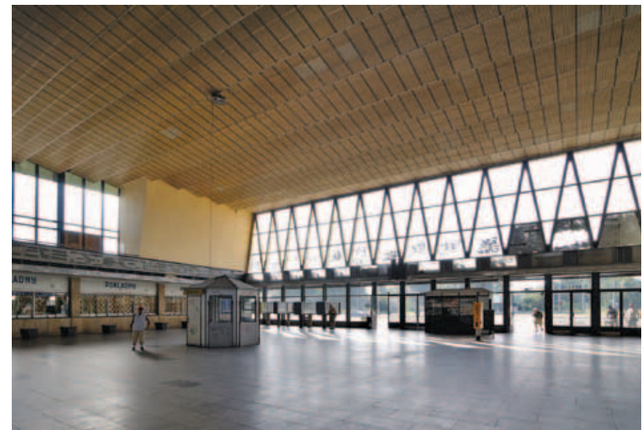
Interiér výpravní haly z úrovně přízemí (foto Roman Polášek, 2014).
