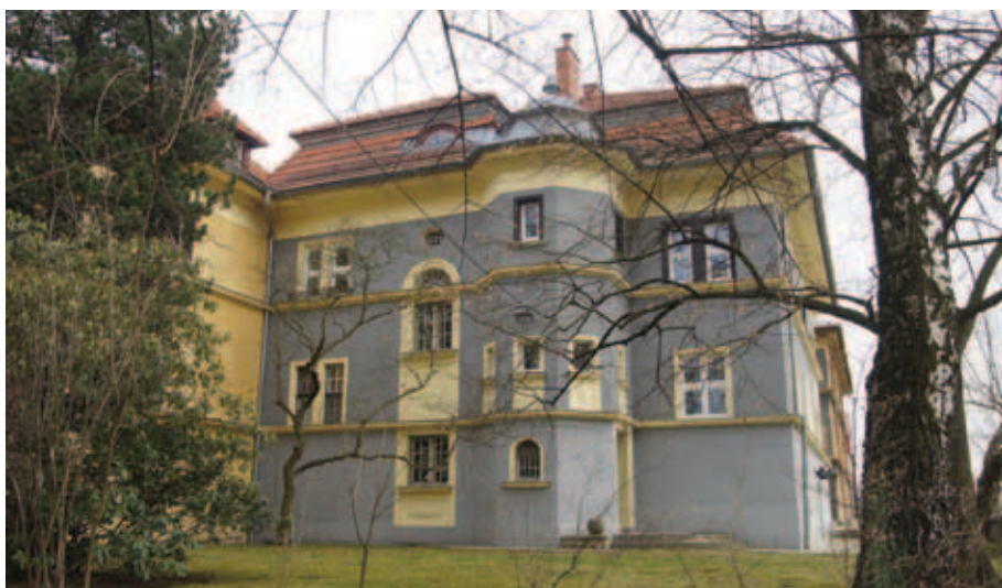
Obytné domy pro státní zaměstnance v Hlučíně od Hanse Kalitty. Pohled na fasádu domu B, navazující na dům A. Současný stav (foto Adam Hubáček, 2015).
