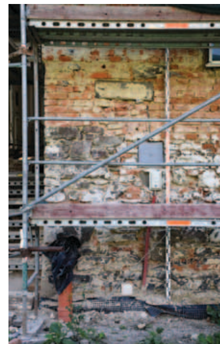
Úsek západní fasády tzv. Müllerova domu č. p. 1 v Opavě s reliktů hlavní městské hradby (foto Jana Koudelová, 2016).
