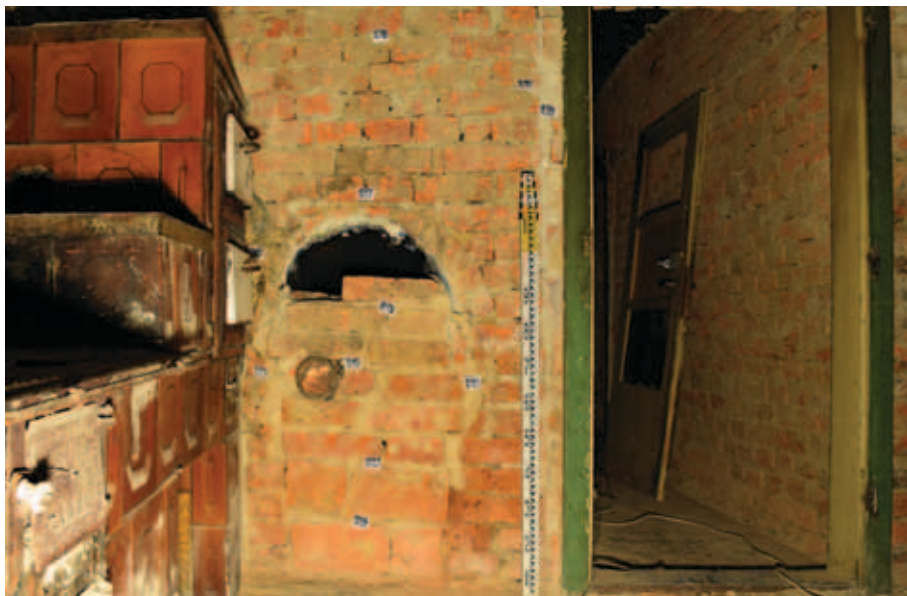
Zazdívkový výklenek v jižní zdi kuchyně v přízemí domu č. p. 3 v Lipině (foto Jana Koudelová, 2016).
