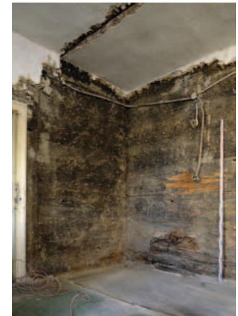
Pohled na část odkrytých roubených stěn velké zadní světnice v přízemí domu č. p. 362 v Příboře (foto Jana Koudelová, 2015).
