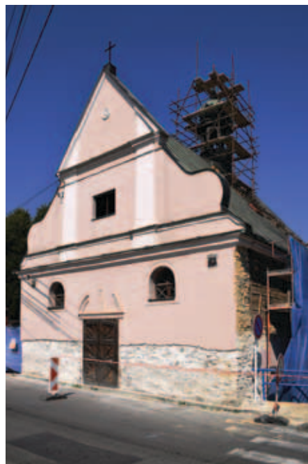
Pohled na západní štítové průčelí kaple sv. Rodiny v Odrách během rekonstrukce (foto Dagmar Alterová, 2015).
