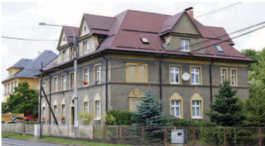
Učitelský dům v Petřkovicích. Boční fasáda. Původní architektonické členění před zateplením fasády. Současný stav (foto Adam Hubáček, 2015).
