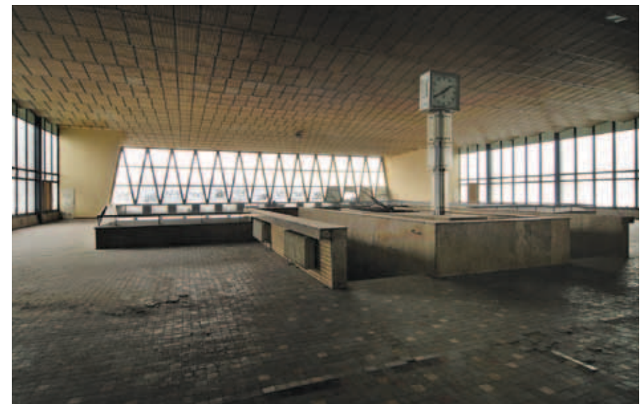
Interiér výpravní haly z úrovně galerie v patře s hodinovou věží od Vladimíra Kopeckého (foto Roman Polášek, 2014).
