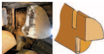
Detail vnitřního zámku použitého u nárožního spoje roubených stěn velké zadní světnice v přízemí domu č. p. 362 v Příboře (foto Pavla Vidomusová, kresba Jana Koudelová, 2016).
