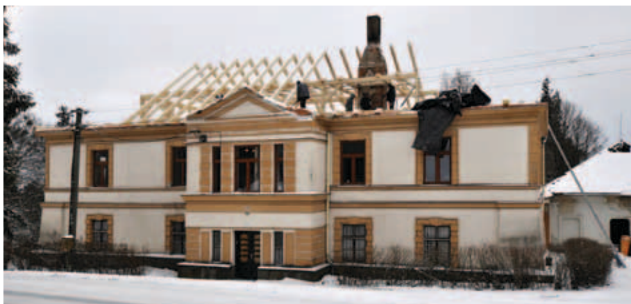
Pohled na hlavní severní průčelí a nově budovaný krov zámku v Dolních Tošanovicích (foto Dagmar Alterová, 2016).
