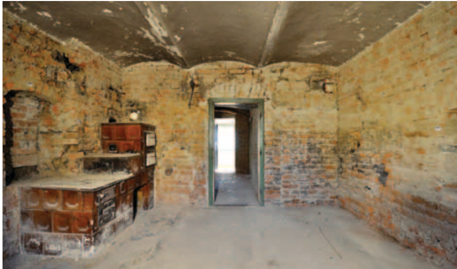
Pohled do jižní poloviny kuchyně v přízemí domu č. p. 3 v Lipině (foto Dagmar Alterová, 2016).
