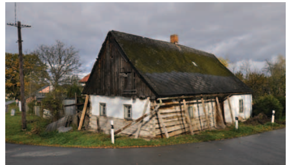
Celkový pohled na dům č. p. 120 v Bohušově od jihu (foto Dagmar Alterová, 2016).
